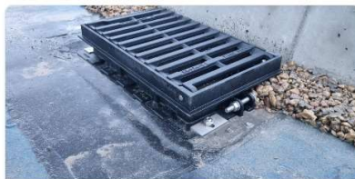
Osazení příruby s rámem a mříží na provedenou izolaci mostovky
