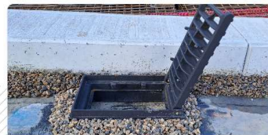
Provedení vrstvy drenážního polymerbetonu kolem celého rámu až pod jeho vrchní rozšířenou část
