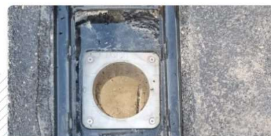
Vložená nerezová odpadní trubka DN150
