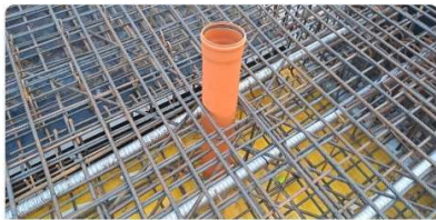
Umístění chráničky odpadní trubky v bednění a výztuži mostu
