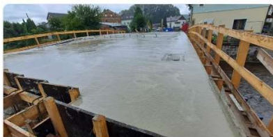
Provedená betonáž mostovky
