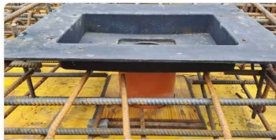
Osazení spodního dílu do bednění s výztuží
