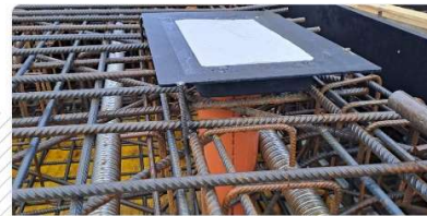
Zakrytí otvoru spodního dílu před betonáží
