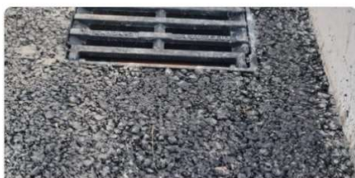
Odvodňovač ve vozovce před provedením závlivky
