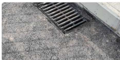
Odvodňovač po provedení závlivky s posypem
